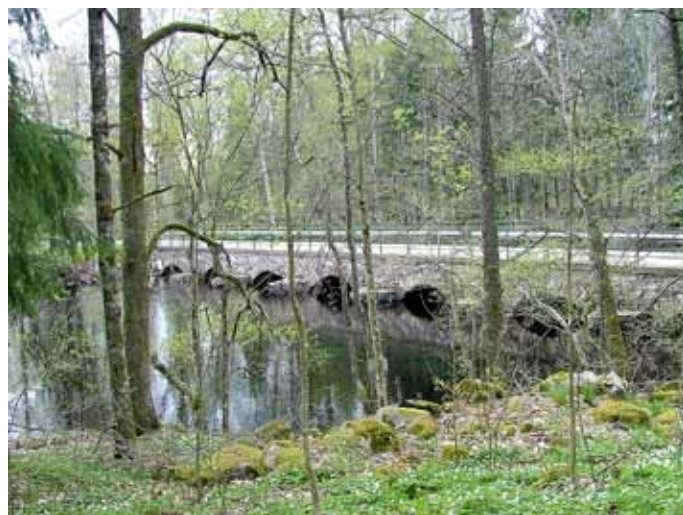
Älvanäsbron i maj 2004. Lägg märke till de V-formade stenpelarna mellan varje spann, vilka fungerar som isdelare.
