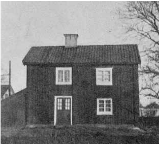
Fattighuset i Tybble som i mitten av 1800-talet ersatte ett tidigare. Foto ur Almbyboken.
