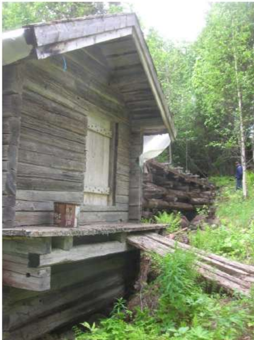
2011-06-14. Kvarnhuset och vattenrännan.
