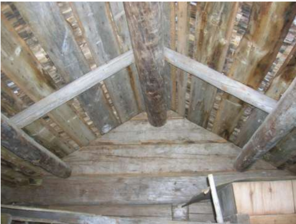
11 06 14. Kvarnens åstak utgörs av en kroppås och en sidås vardera med glest rote av vankantade bräder med stickspån.
