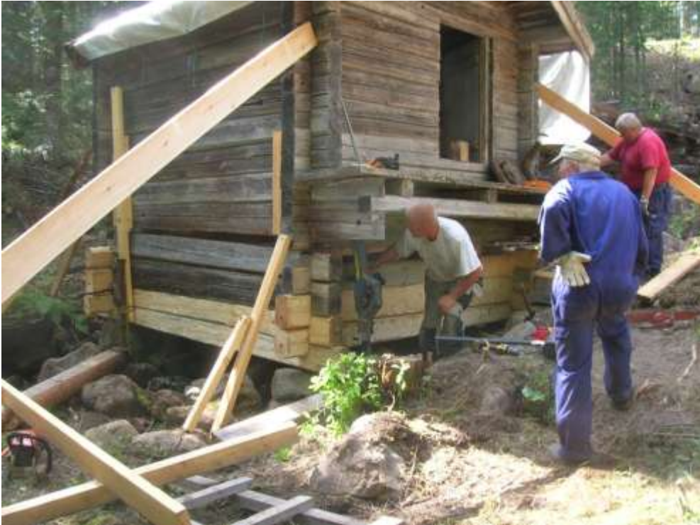
11 08 03. Man släpper efter med domkrafter, tråklossar och stöttor allteftersom nytt timmer placeras in på rätt ställe.
