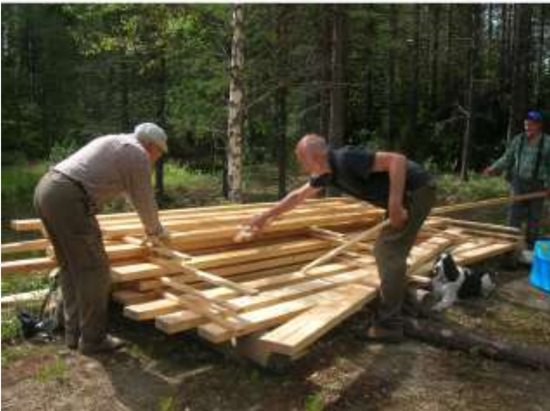
Sortering av bräder som ska sågas för inpassning av spont.
