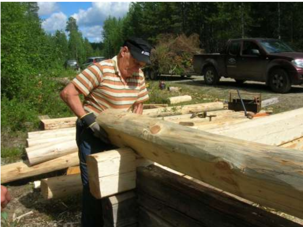
11 07 29. Nytt timmer för kvarnens nederdel putsas av med bandkniv och timras in för att ersätta en rötskadad stock
