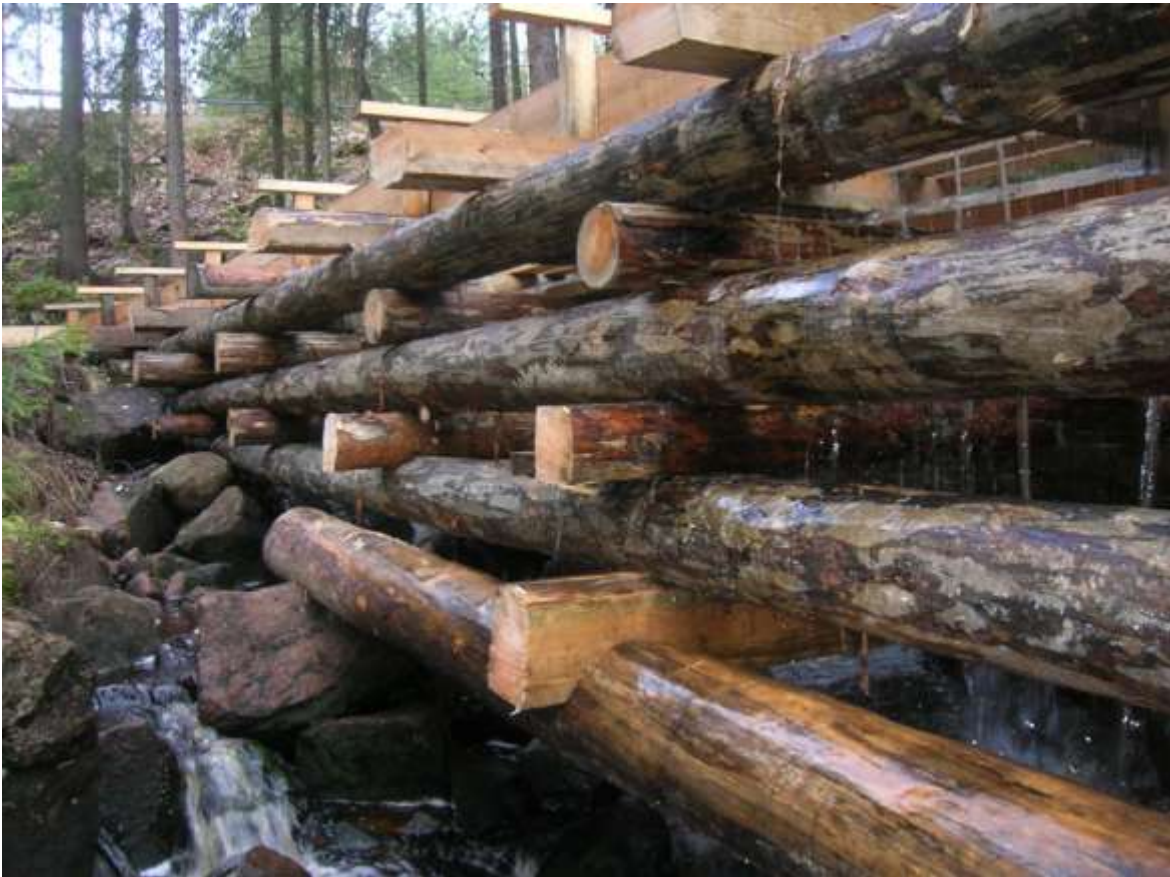
2011-10-12. Vattenrännans östra sida efter rekonstruktion.
