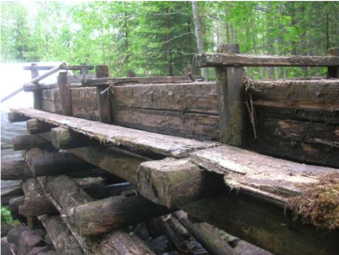
2011-06-14. Vattenrännans västra sida före rekonstruktion.
