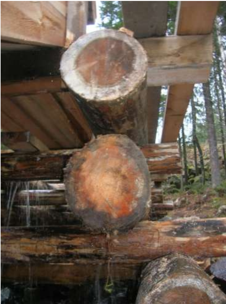
2011-10-12. Underbyggnadens kortsida mot kvarnen.
