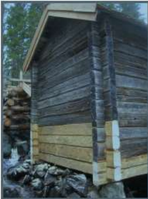
11 10 12. Östra väggen (kvarnhusets baksida).
