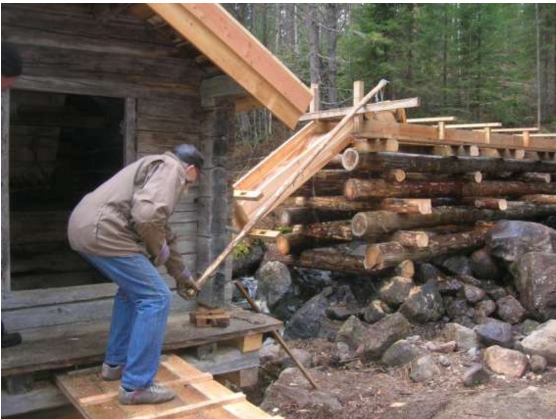
2011-10-12. Hembygdsföreningens ordförande Fredrik Svedberg öppnar luckan för vattnet, som driver kvarnen.
