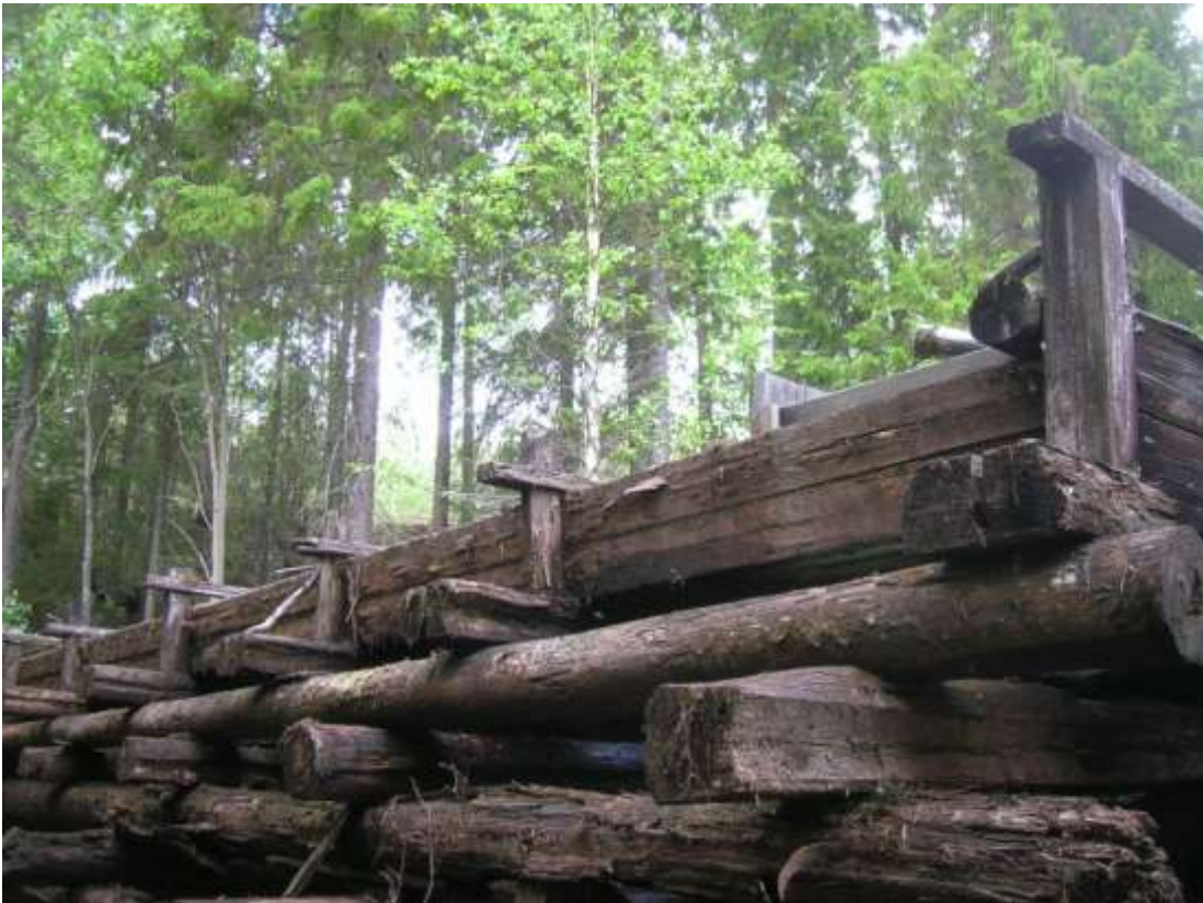
2011-06-14. Vattenrännans östra sida före rekonstruktion.
