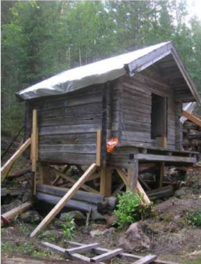
11 07 29. Det uppallade kvarnhuset.
