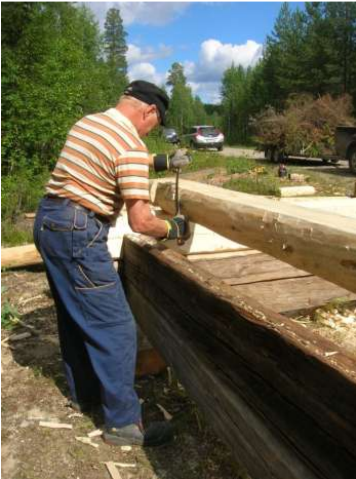
11 07 29. Nytt timmer för kvarnens nederdel putsas av med bandkniv och timras in för att ersätta en rötskadad stock
