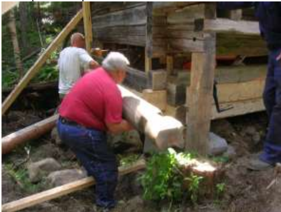
11 08 03. Man släpper efter med domkrafter, tråklossar och stöttor allteftersom nytt timmer placeras in på rätt ställe.
