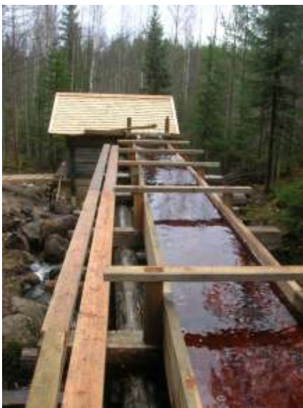
2011-10-12. Rekonstruktionen av vattenrännan.
