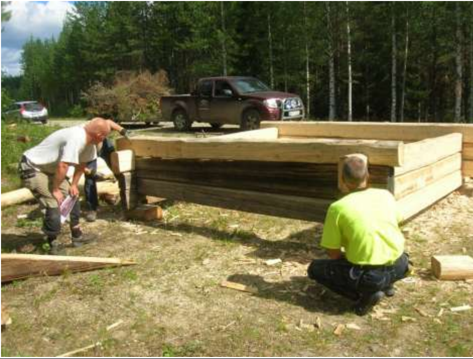
11 07 29. Arbetslaget för dagen i arbete under Marcus Lindgrens ledning.
