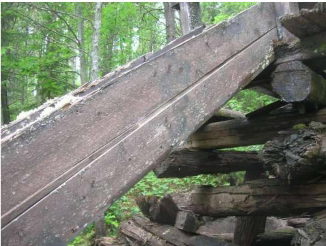
Vattenrännans västra sida före rekonstruktion. Änden av gammal telefonstolpe th.
