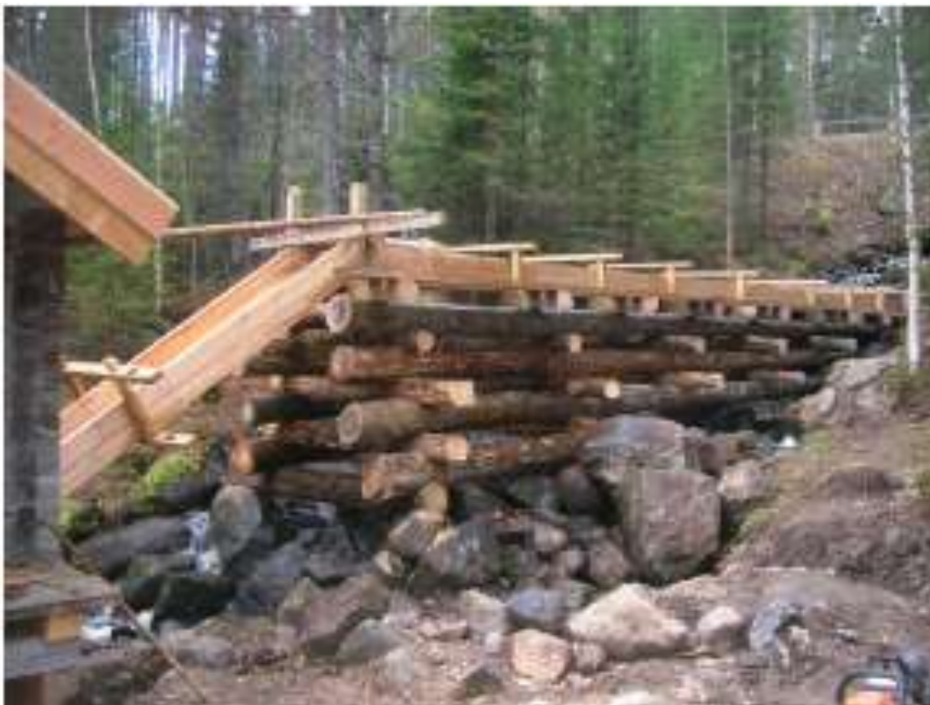
2011-10-12. Vattenrännans västra sida efter rekonstruktion.
