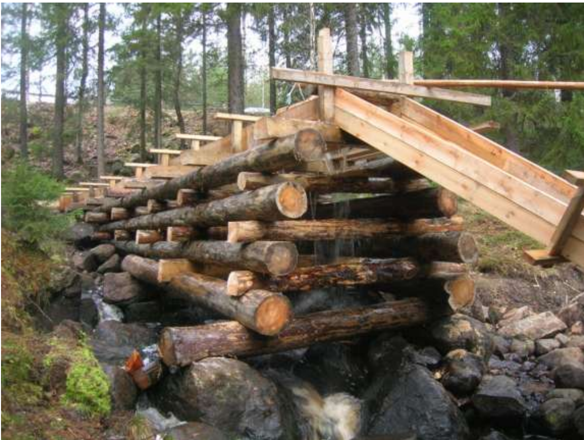
2011-10-12. Vattenrännans östra sida efter rekonstruktion.
