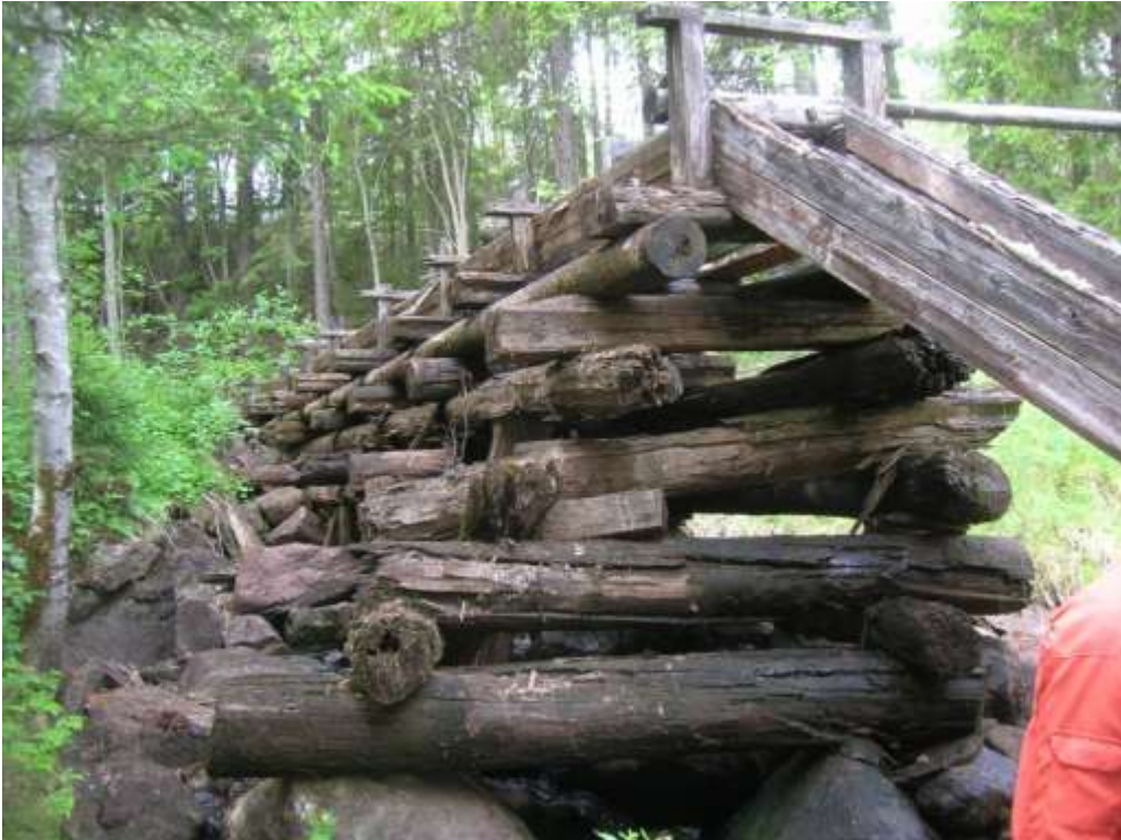
2011-06-14. Vattenrännan av bräder, underbyggnaden av äldre hugget eller sågat rundtimmer och återanvänt timmer från gamla hus. Östra sidan, Foto mot vägen i söder.
