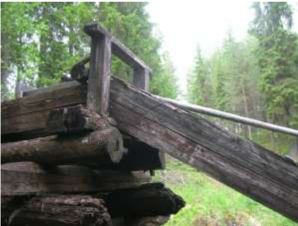
2011-06-14. Vattenrännans östra sida före rekonstruktion.
