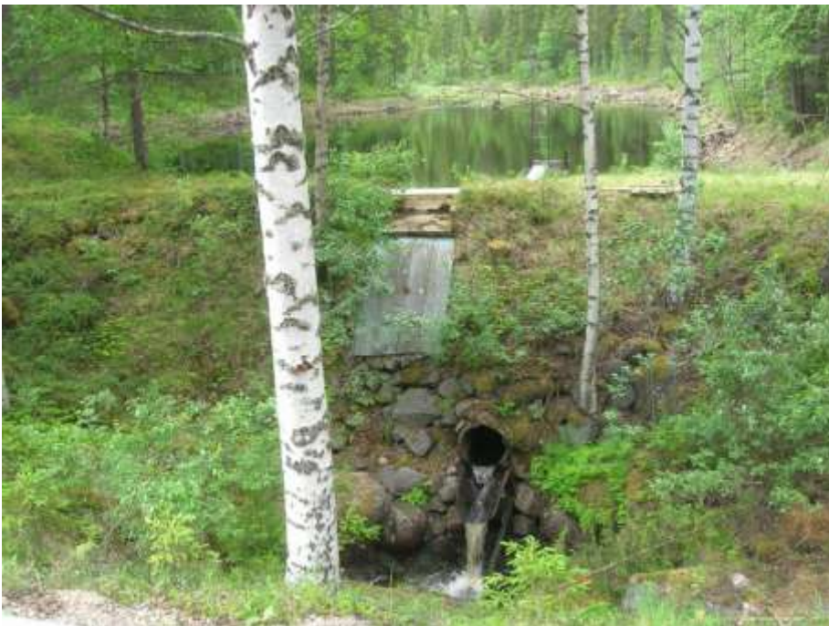
11 06 14. Dammens utlopp på ovansidan byvägen.
