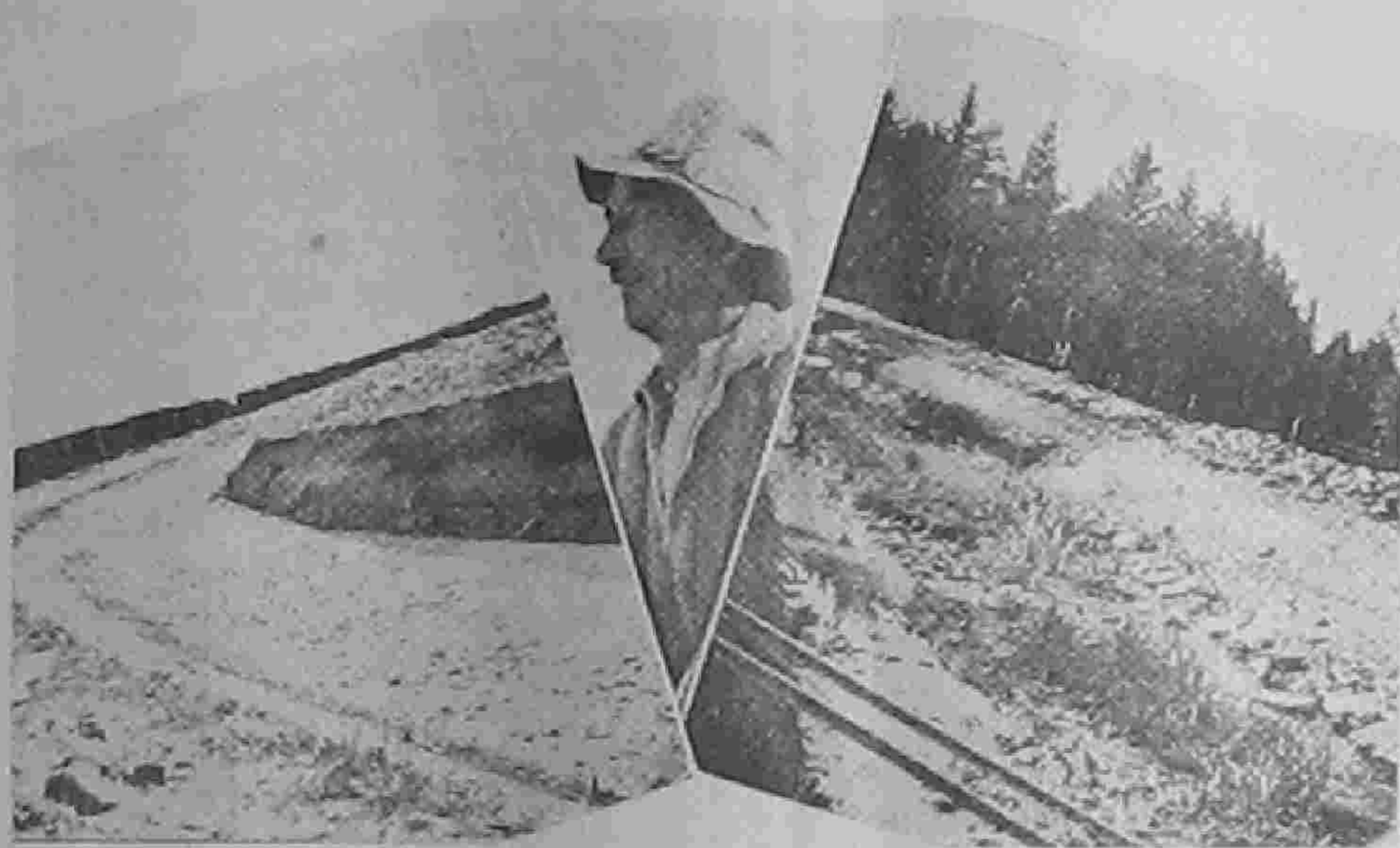
Härovan ses ett par bilder från kanalarbetet, å ena bilden kanalrännan, å den andra synes rälsten för uppfodringsverket, varom berättas i artikeln. Infälld: arbetsledare A. Ekström.
