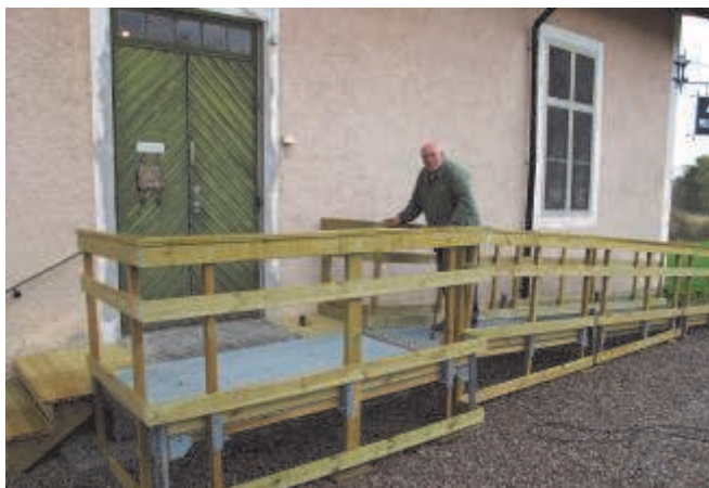
Test av småskolans ramp
