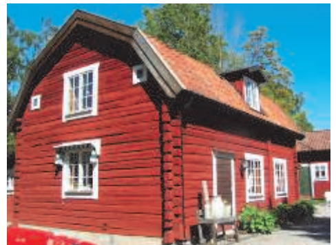
Tvättstugan efter flytt och renovering
