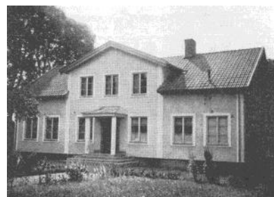
Ekeby Herrgård från norr. Efter mordbranden kom denna byggnad till år 1870.
