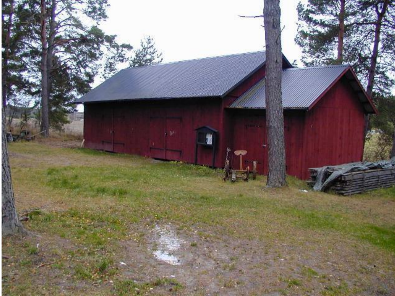
Vagnslider och förråd
