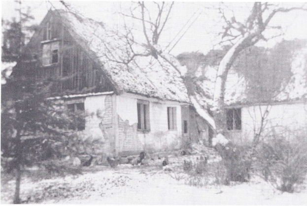
Rivningen av klockargården slutet 1947.
