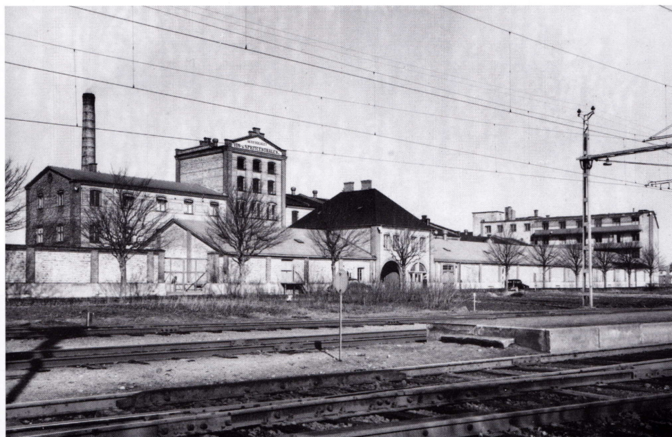
Spritcentralen i Ödåkra
