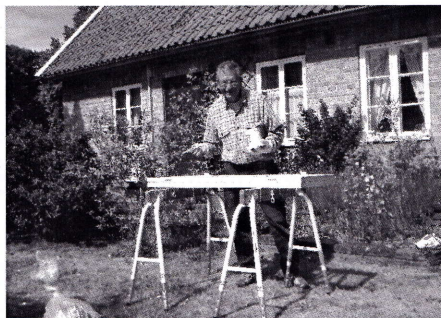
Muséiebyggnadens fönster målas.
