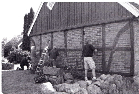
Korsvirket i korsvirkeslängan renskrapas.
