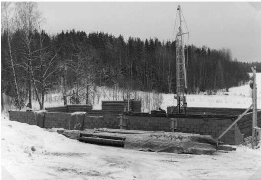
Den första delen av det som ska bli Skifwegården byggs
