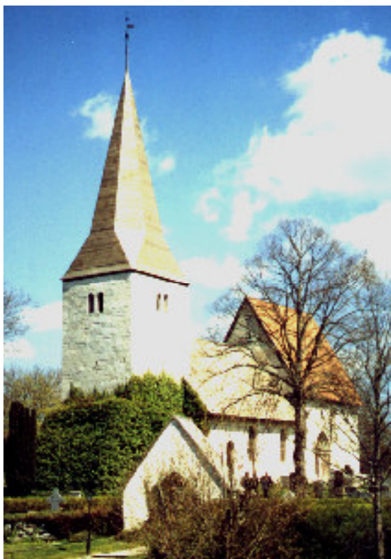
Fröjel kyrka. Kyrkor med högre kor än långhus kallas sadelkyrkor. Koret är då ombyggt till gotisk stil medan resten av byggnaden står kvar i romansk stil.
