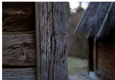
Ett bulhus. I de lodräta stolparna finns spår, där plankorna, de så kallade bularna, kan läggas ner. Springorna tätades med mossor och lera. På Gotland användes ofta ag till takläggningmaterial.
