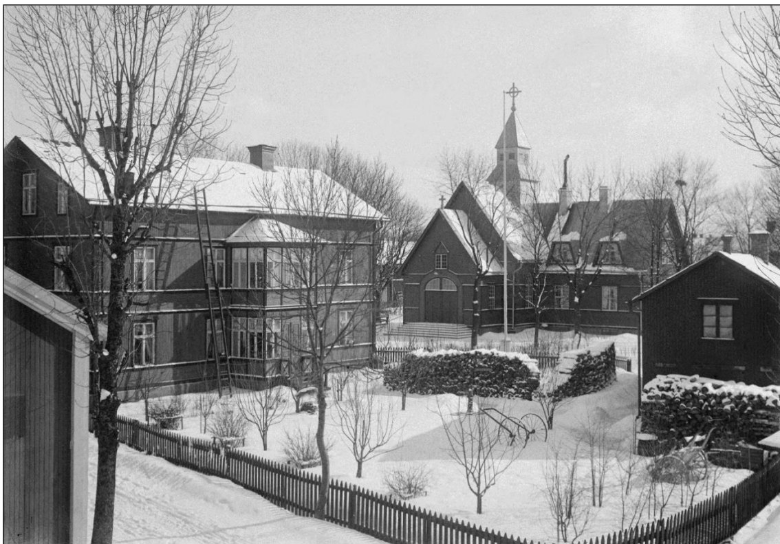
Missionskyrkan invigdes 1912 då det gamla huset blivit för litet. Byggnaden fanns kvar till början av 1990-talet, då den ersattes av den nuvarande Ekumeniakyrkan. På fotot ser vi till vänster det då nybyggda Apoteket vid Sjötorget.
