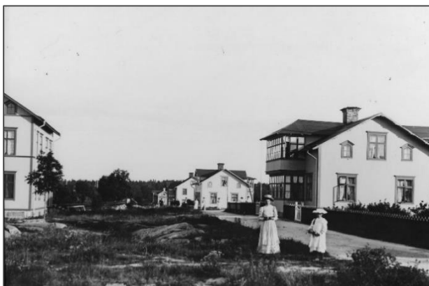
Hus vid Rådmansgatan, notera att gatan idag är utflyttad mitt emellan husen på bilden
