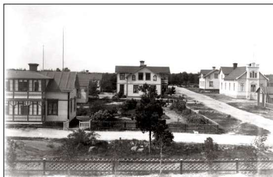
Korsningen Rådmansgatan Högbergsgatan med bland annat Frälsningsarméns lokal.
