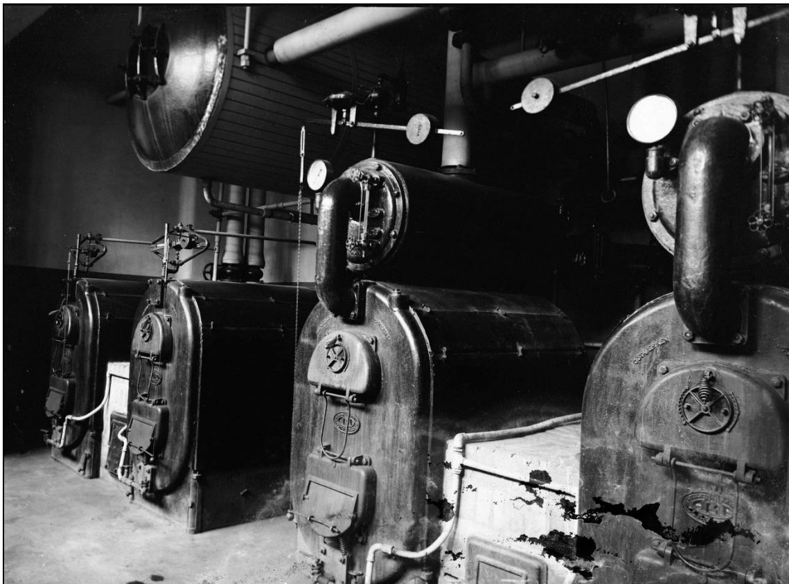
Pannrum på nya lasarettet omkring 1920. Lasarettet eldades under många år med ved.
