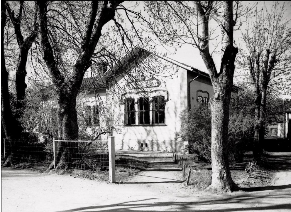
Skolhuset invid Drottninggatan byggdes i början av 1880-talet. Bilden togs vid sekelskiftet 1900. 1948 byggdes huset om till tvåvåningshus (Brunnsskolan).
