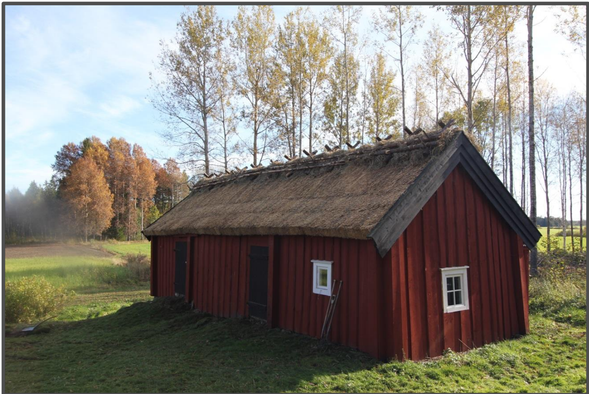
Uthuset, med vasstaket som byttes 2011
