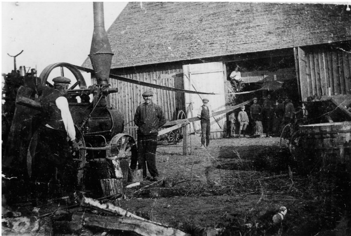
Tröskning med lokomobil 1915 hos Anders Pettersson, Skepparslöv nr 4. Vedhuggare A. Pettersson, maskinist Per Paulsson.
