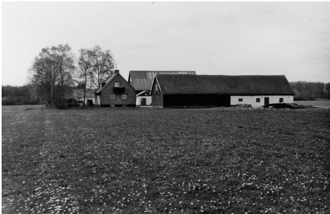
Venestad 58:1, Rävshult, Rävshultsvägen. Egna hem från början av 1900-talet. Ekonomilängan i förgrunden var den enda byggnaden till att börja med, med bostad i den vänstra, södra delen. Fr. OSO.
