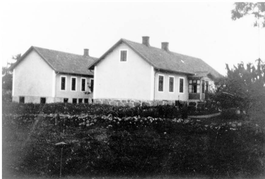
Örmatofta skola från norrsidan, baksidan. Adells bodde i hitre delen av högra längan; en gymnastiksal invigdes i den vänstra längan 1932.
