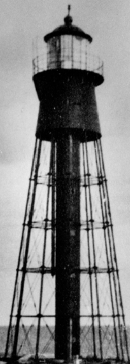
Hărădskårs fyr var den första svenska fyren med roterande lins. Fyrornet är av järn och ritat av Gustav von Heidenstam. Fyren tändes 1863. Det första fyrljuset bestod av en rovoljelampa. År 1887 byttes rovoljelampan i fyren ut av en fotogentid År 1908 fick man Lux - ljus och 1943 installerades Agaljuset. År 1960 elektrifierades fyren och fyrmästaren, som de sista åren skött fyren ensam, flyttade.
