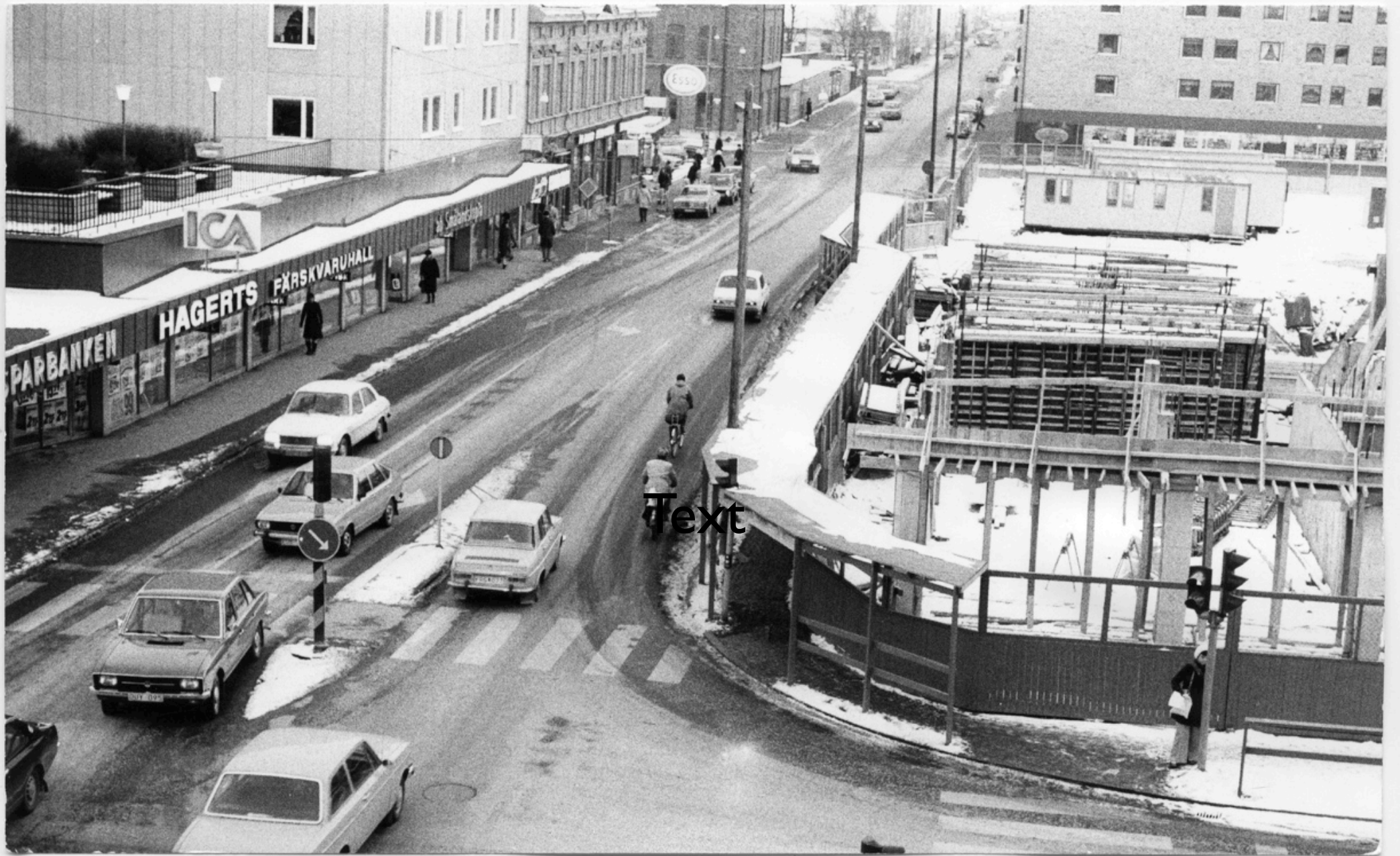
Det nya hörnhuset vid Klostergatan under byggnad, 1976
