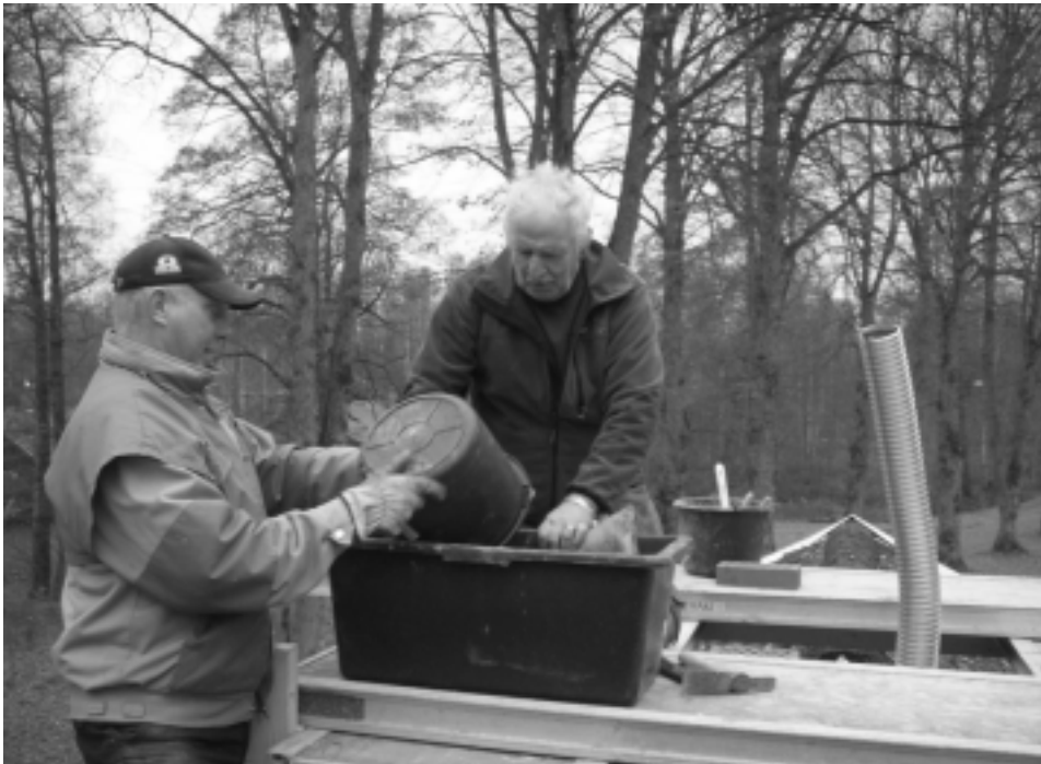
Tveta Byggs Thor-Erik Rydén och Kennert Geijersson murar upp skorstenen på hembygdsstugan i Åryd. Se text sid 9.
