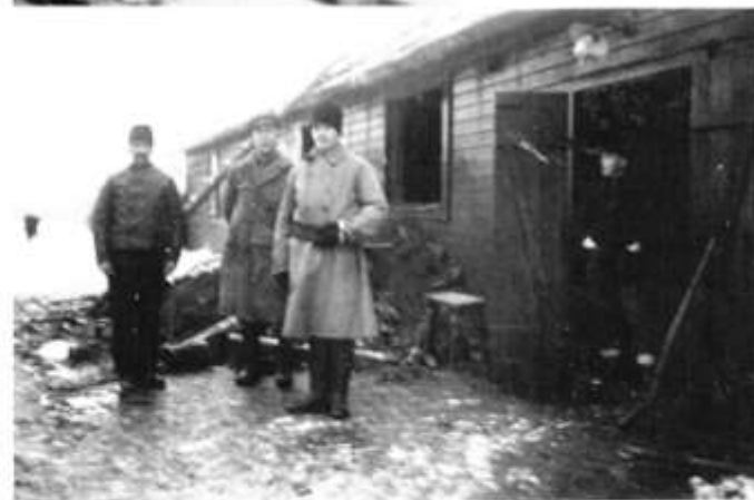
Bilden när arbetet är utfört visar brandmännen fr.v. Arvid Larsson, Einar Lönn och Axel Brew efter väl utfört arbete. I dörren står trädgårdsarbetare Karl Lidén och begrundar förödelelsen.
