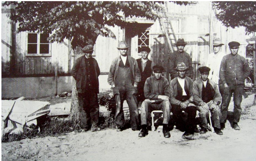
Wilssonska huset byggs. Fr. v. elmontör Karl Börjesson, byggmästare Alfred Karlsson, montör Gustav Andersson, snickarna Albert Henriksson, Albin Johansson, Albert Larsson, Johan Henriksson och Harald Sandahl, mannen i vitt är okänd. Foto från 1929.
