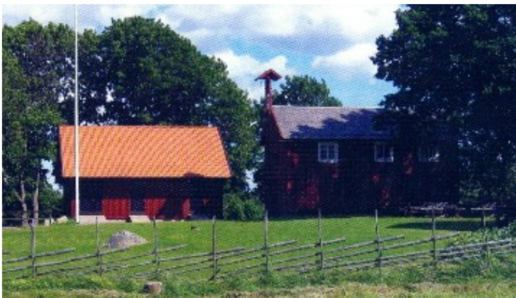
Det gamla magasinet (t.h.) och det nybyggda förrådshuset.
