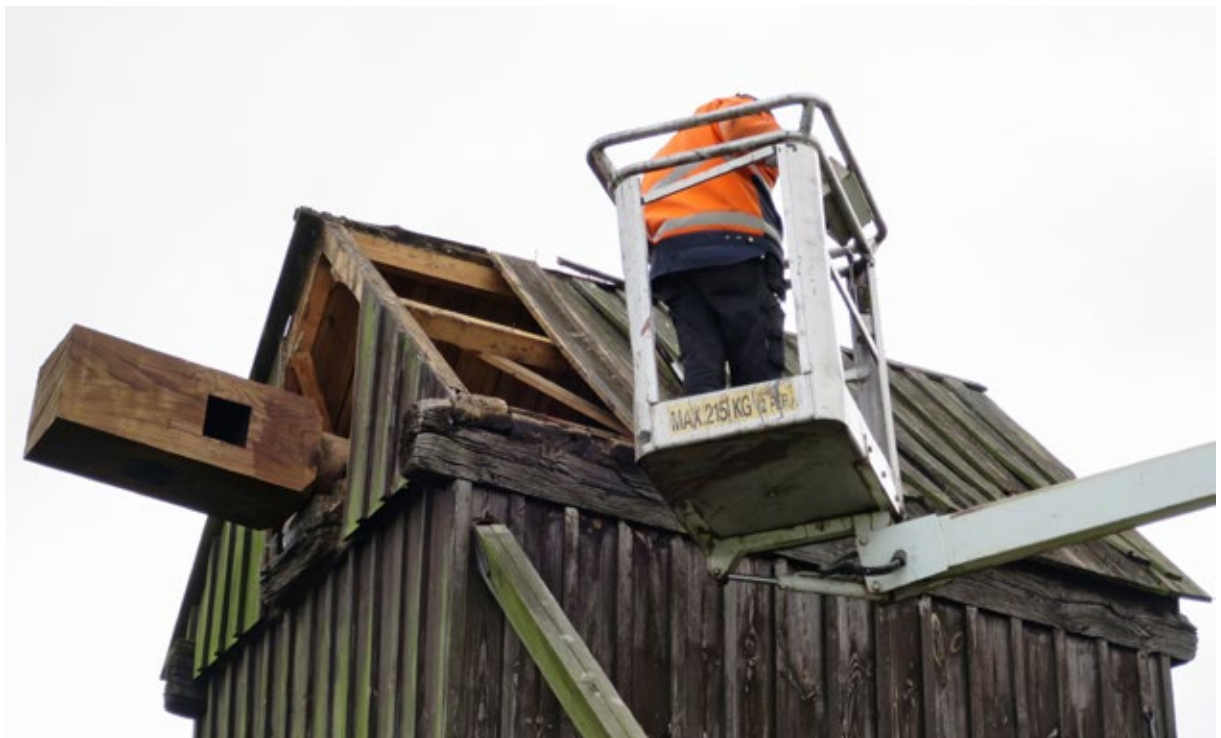
Rivning av det gamla taket.
