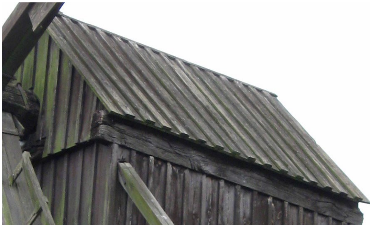
Taket före renovering.
