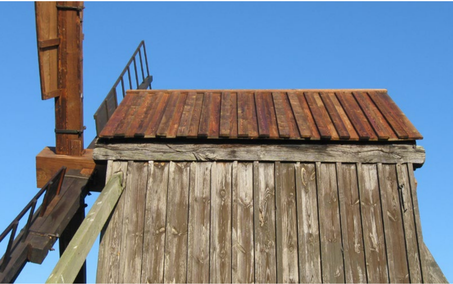
Ny brädtäckning ochnockbräda på ett takfall.
