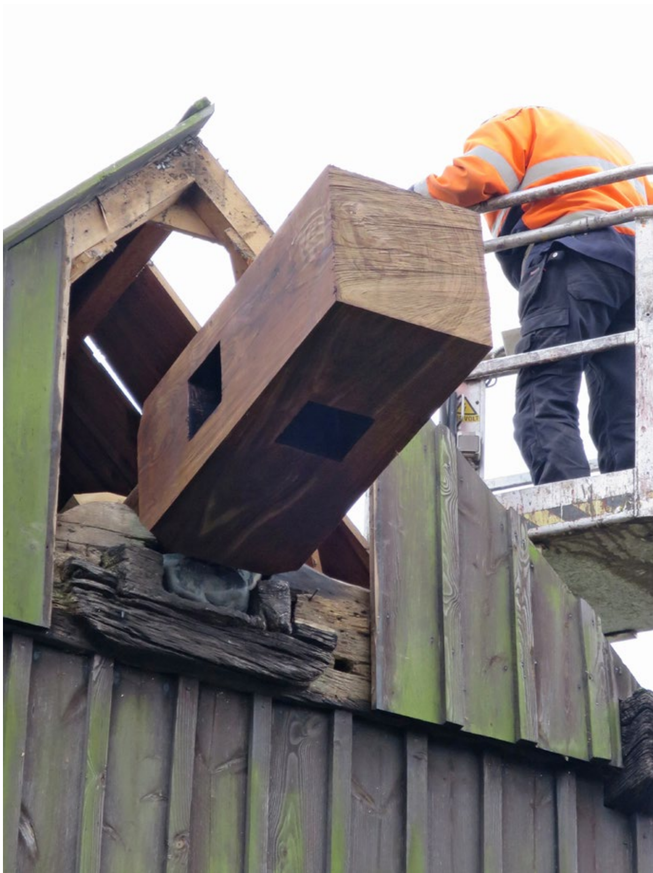
Ny gångås på plats och läggning av nytt brädtak.
