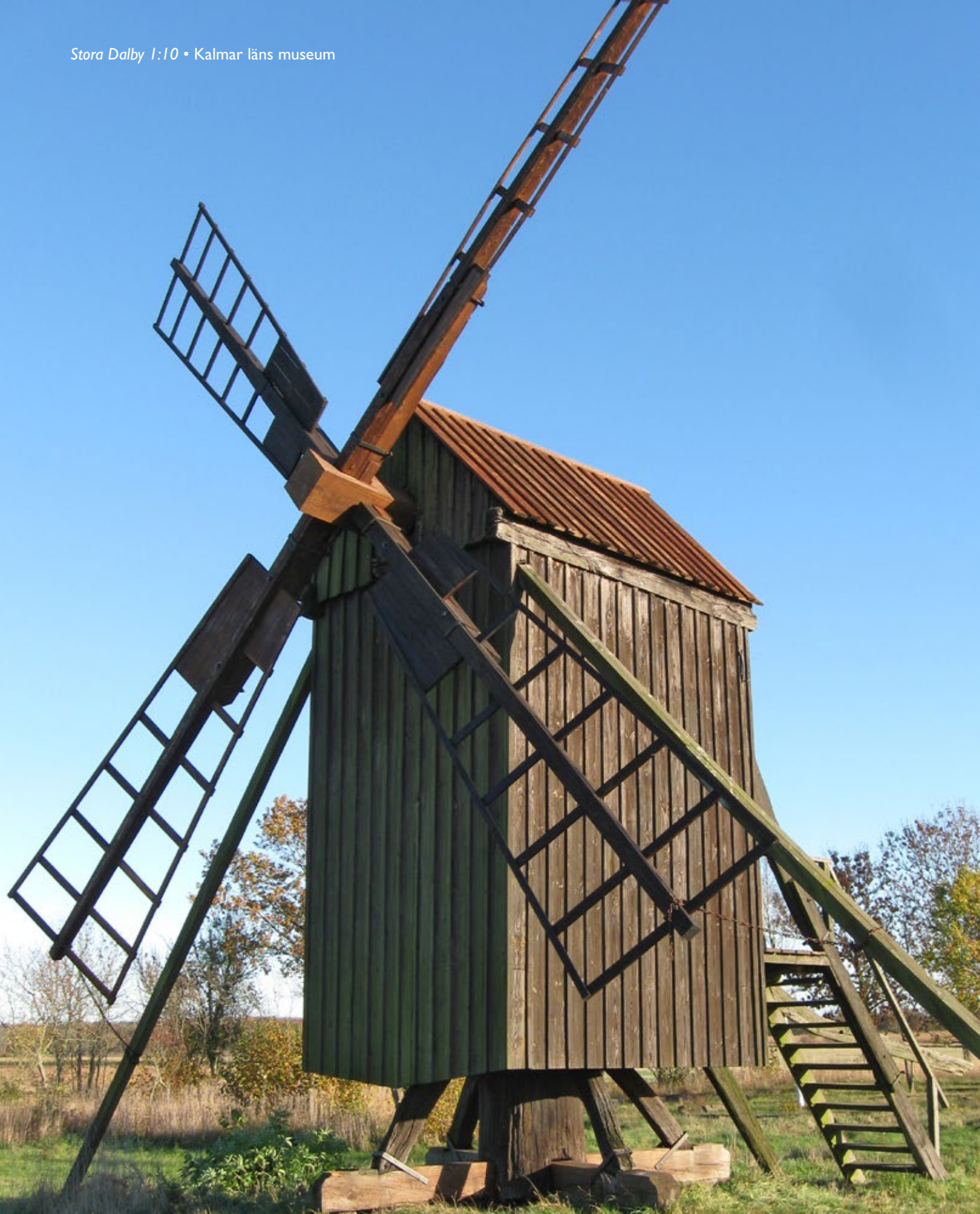
Kvarnen efter renovering av två vingar, tak och gångås.
