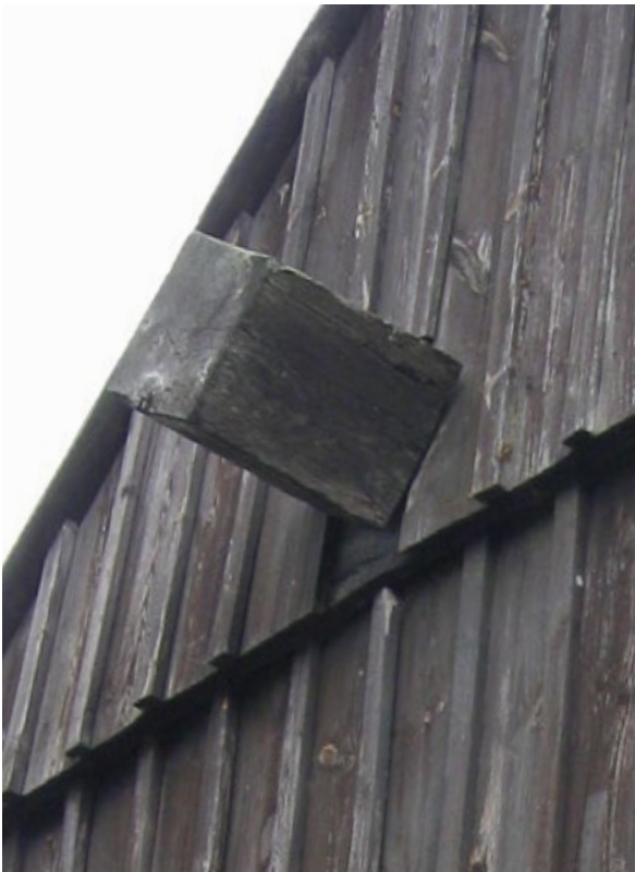
Gångåsen före byte, kvarnens baksida.
