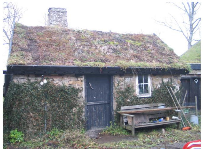
Vänster: Byggnaden sedd från norr under pågående arbete resp. efter utförda åtgärder. Torven utmed kanterna togs bort för att kunna byta mullbrädernas och vindskivornas fästen och komplettera takpappen.
