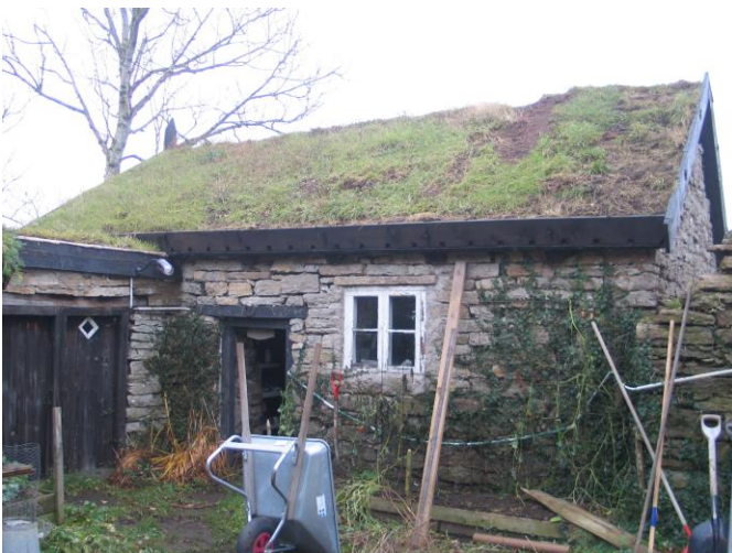
Byggnaden sedd från väster efter utförda åtgärder.
