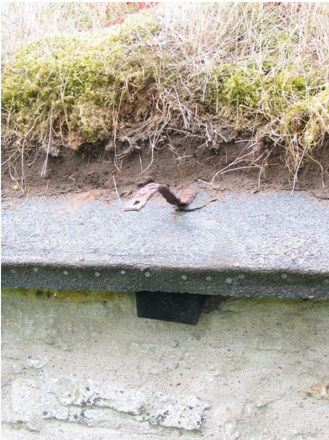
Detalj av mullbrädernas fästjärn vid takfot, varav vissa var avrostade.
