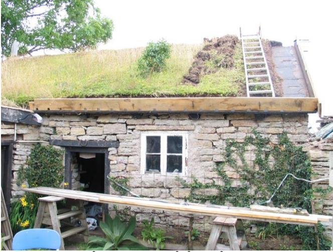
Byggnaden sedd från väster under pågående åtgärder.
