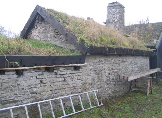
Ovan: Ett långsgående plattjärn har fästs utmed gavlarnas takutskott för att stadga undertaket mot vilket vindskivorna spikas.
