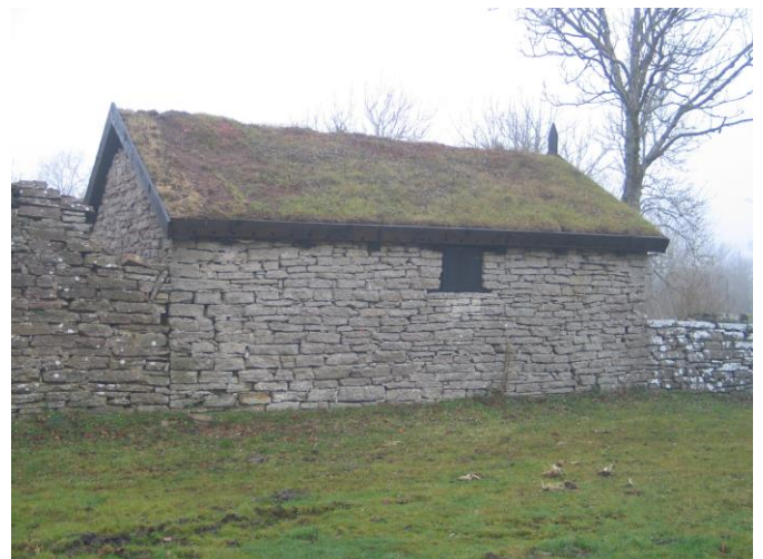
Byggnaden från öster efter utförda åtgärder. Till vänster skymtar stenkällaren.
