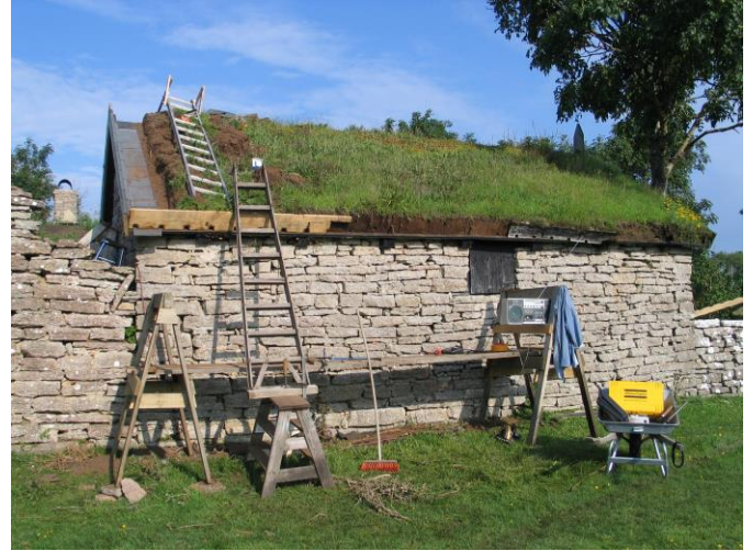
Under pågående arbete med mullbräda utmed östra långväggen.
