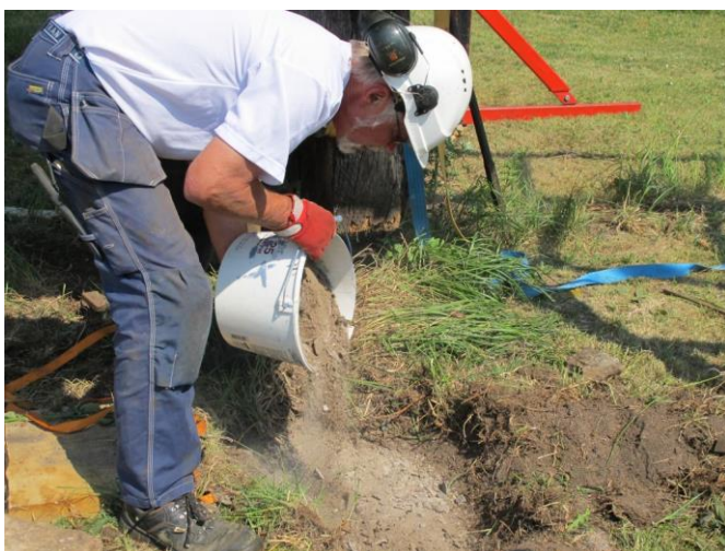
Arbetet med att lägga kvarnstenarna på plats som stöd under jordträna börjar med grundning med sand.
