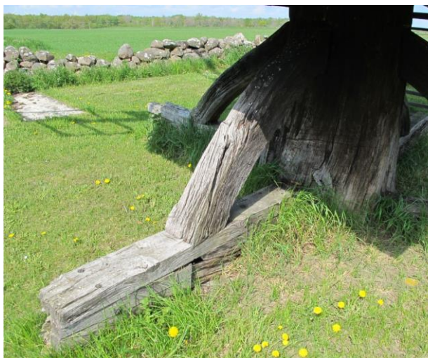
Före mot söder. Här pålappningar och lagningar.
