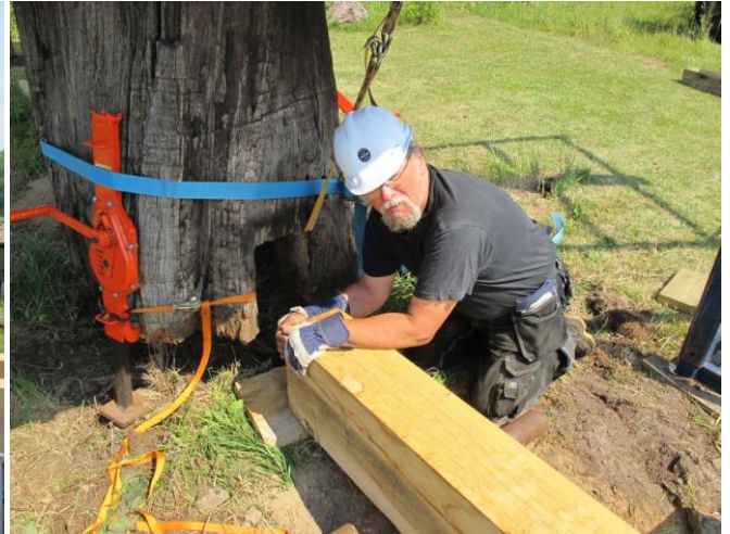
Det första nya jordträet dras in på plats med hjälp av spännband som viras upp med hjälp av en eldriven motor. Inpassningen är noga.
