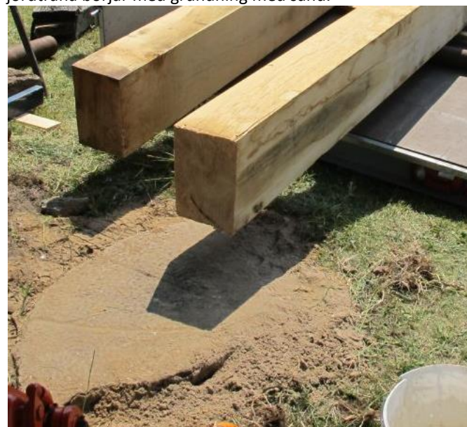
Arbetet med att lägga kvarnstenarna på plats som stöd under jordträna börjar med grundning med sand.
