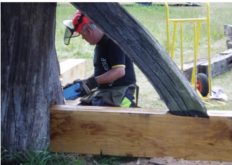
Så här blev det med de nya tjärade jordträna och de återanvända infällda stubbstöttorna. Foto Monica Rasch.
