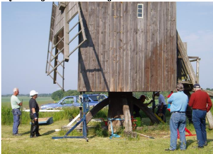
Montering av domkrafter i fyra hörn och i mitten pågår. Stöttorna plockas bort. Foto Monica Rasch.
