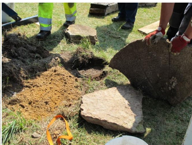
Arbetet med att lägga kvarnstenarna på plats som stöd under jordträna börjar med grundning med sand.
