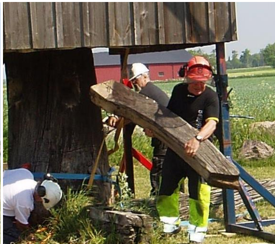
Montering av domkrafter i fyra hörn och i mitten pågår. Stöttorna plockas bort. Foto Monica Rasch.
