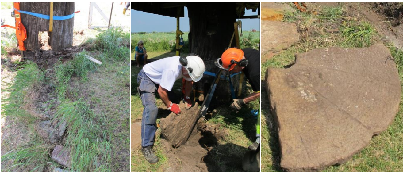
Under jordträna låg många små kalkflisor samt under dem \frac{1}{4} av en delad kvarnsten, under alla fyra jordträn. Dessa fyra kvarnstenar plockades fram.
