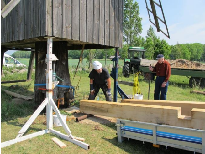
Det första nya jordträet dras in på plats med hjälp av spännband som viras upp med hjälp av en eldriven motor. Inpassningen är noga.
