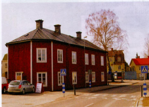
Gästgivargårdens byggnad 2009. Istället för att restaurera den vackra putsfasaden, med sina utsmyckningar, har man på 1980-talet bytt fönstren och spikat på en intetsägande träpanel.
