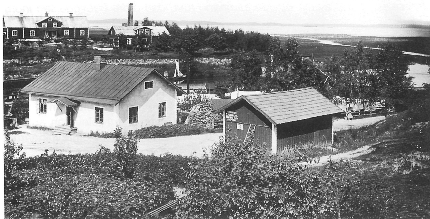
Längst bort t. v. Kungsladugårdens arbetarbostad uppförd av timmer från hovfruntimrets byggnad som nu är hembygdsgård. T h. Mejeribyggnaden. I förgrunden, brovaktarstugan.
