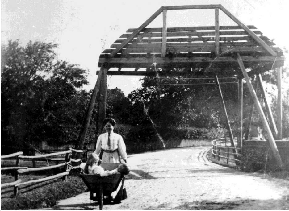
Linbanan för transport av torv från Lundsmossen till Landvetters järnvägsstation korsar här Byvägen. Ett skydd för nedfallande torv har satts upp över vägen. Bild från tidigt 1900 tal.
