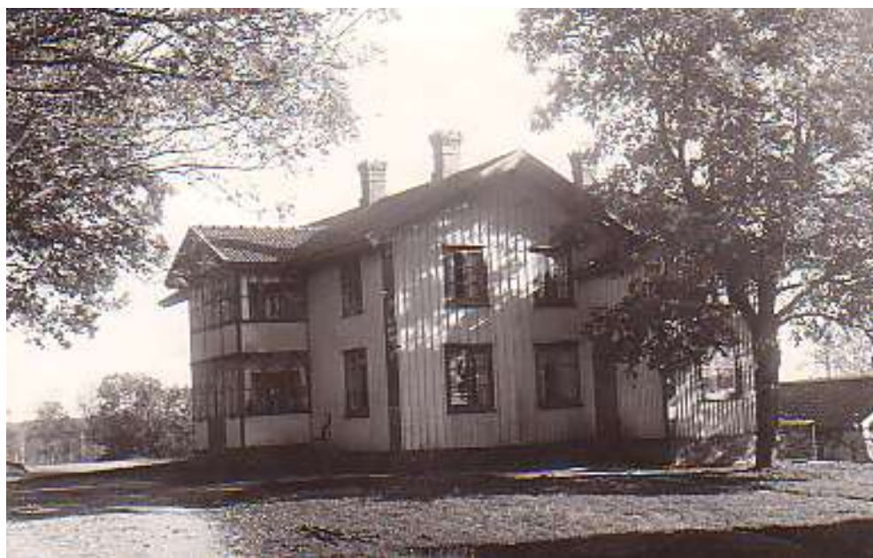
Mangårdsbyggnaden före renoveringen.
