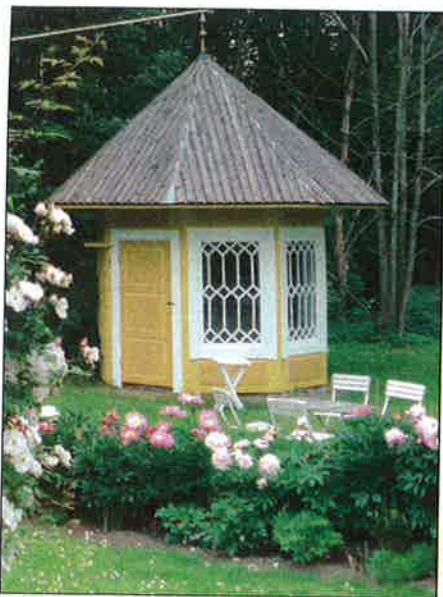
Den gamla vattenkiosken är rekonstruerad över hälsobrunnen på 1950-talet. De öppningsbara fönstren är original.
