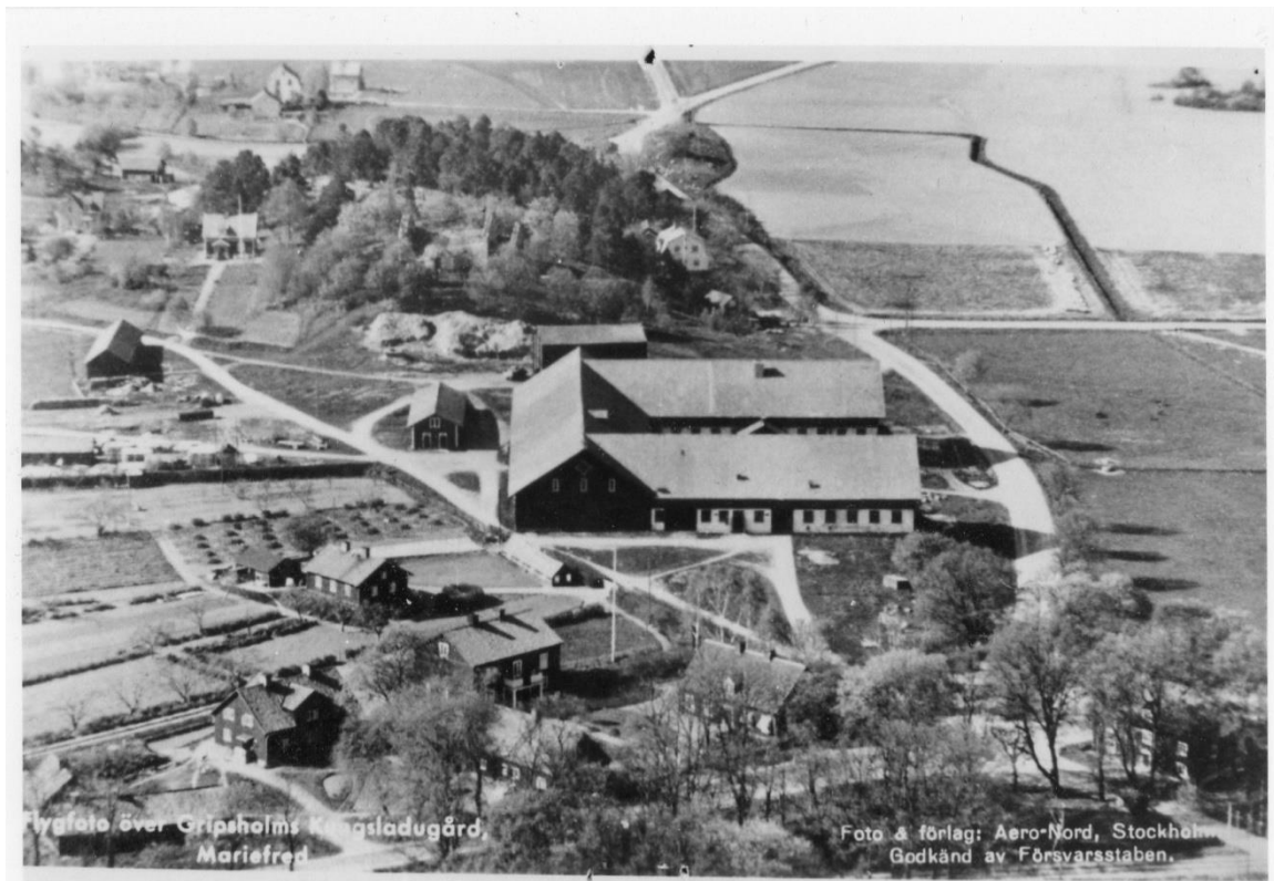
Flygfoto över Gripsholms Kungsladugård.
