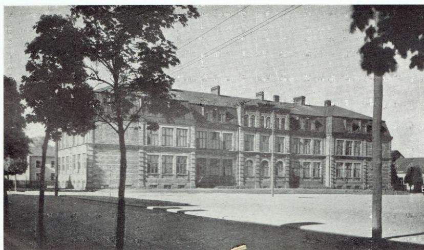
Centralskolan efter till- och ombyggnaden.
