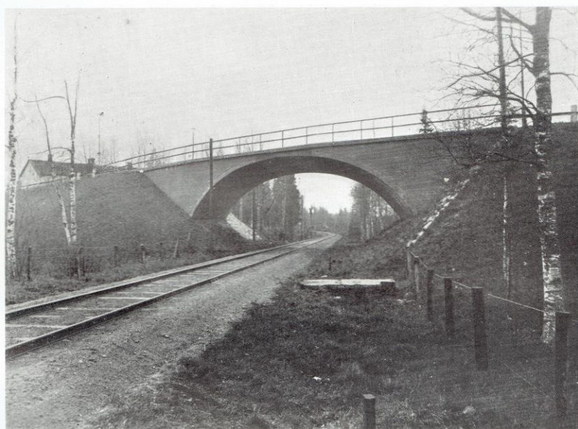
Viadukten över Oskarshamns-banan i Egna hem.
