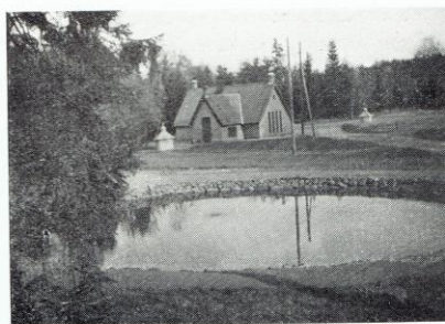
Pumpstationen vid Lugnet.
