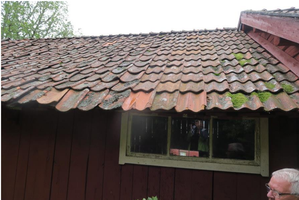
Enkupigt och tvåkupigt taktegel på baksidan. Här syns även en höjdskillnad i taket.
