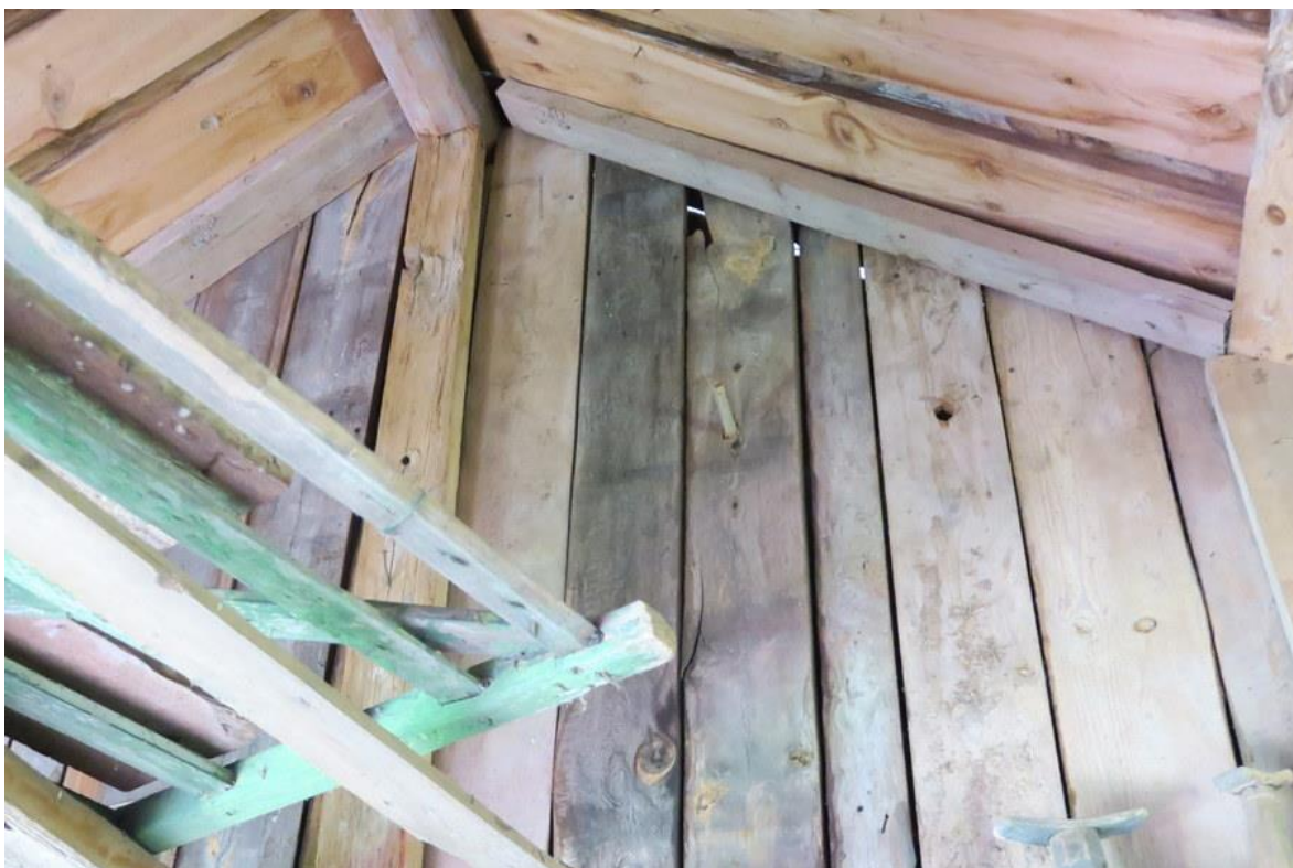
Väggen mot den förhöjda delen.
