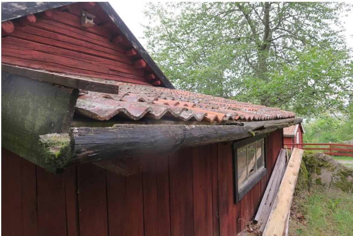
En mindre tillbyggnad på västra gaveln, täckt med tvåkupigt tegel och med en hängränna av trä.
