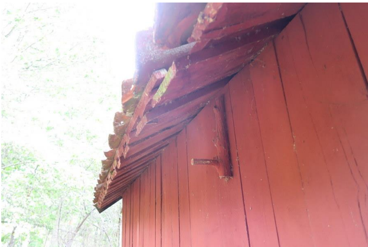
Del av undertaket synligt på baksidan.
