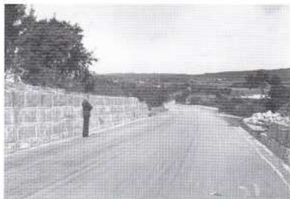
Vägbygget med granitmurarna klart för inspektion.
