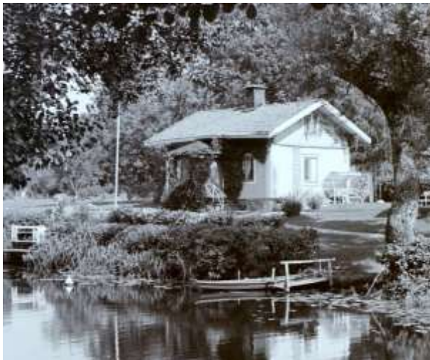
Slussvaktarbostaden 1971 Foto Dag Unevik
