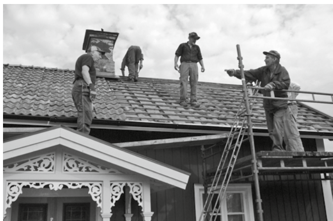
Det gamla takteglet plockas ned.
