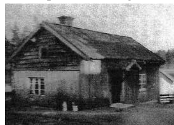
Timmerstugan vid kullen, nybyggd och inflyttningsklar år 1829. Brädfoder på norra gaveln och östra sidan fram till förstukvistens är av senare datum. Foto omkr. 1932.
