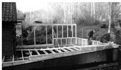
”Byggherren” Christer Ottosson med medhjälpare i arbete med utbyggnaden av kaffestugan.
