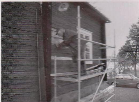
Leif Göran lagar yttervägg.
