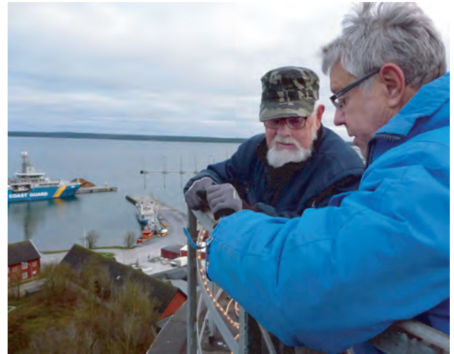
Montering av julbelysningen på vattentornet
