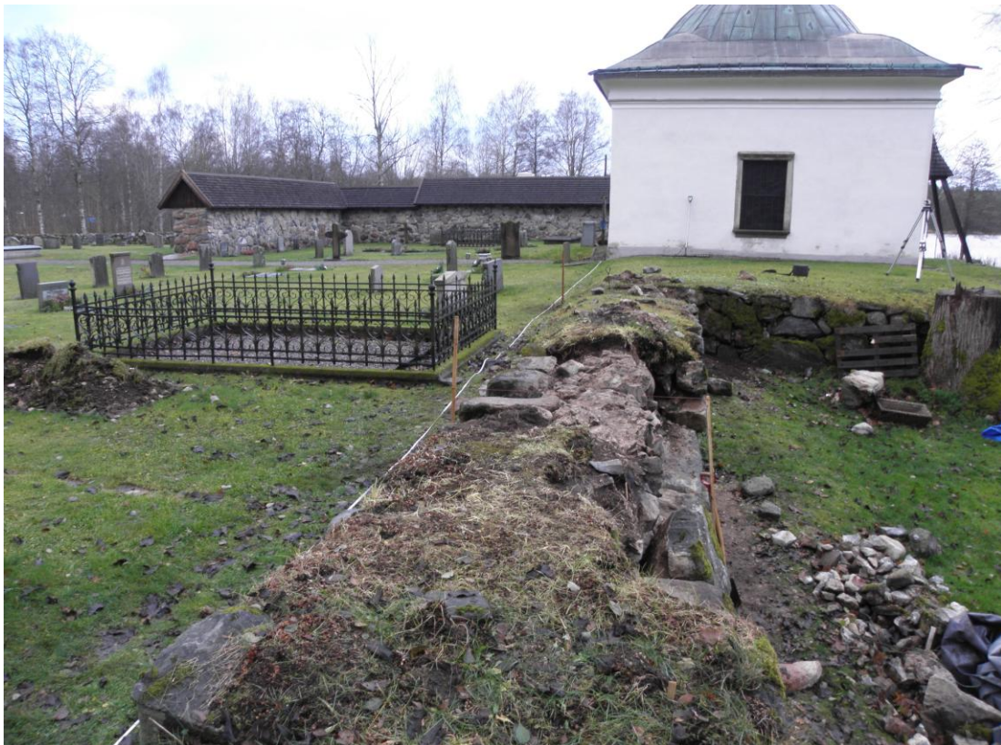
Ramundebodas kyrkogård. I bakgrunden ses ”Munkarnas mur”, troligen en del av ruinen av en kyrka som aldrig blev färdig. I förgrunden ses nuvarande kyrkogårdsmuren som antagligen ursprungligen uppfördes som en del av kyrkans södra vägg. Foto: Jonas Ros.
