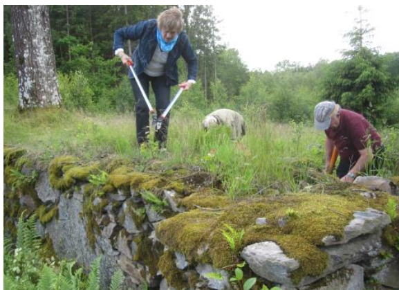
Underhållet kring våra torpruiner är viktigt om de ska bestå i framtiden. Man måste klippa bort buskar och uppväxande träd, för annars spränger rötterna sönder stensättningarna. Här gör Luipold och Ellen ett gott dagsverke. Foto: Gun Larsson.
