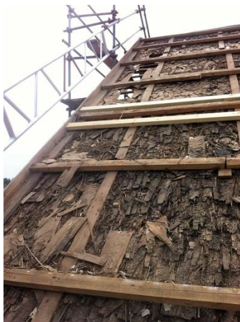
Upptill: Stickspånen var i dåligt skick. Här och var syntes lagningar, där spånen var bättre. Mitten: Där stickspån saknades skedde komplettering. Ny läkt spikades. Nertill: Spånen på norra takfallet. Fotot t.v. taget av Kent Nyberg.
