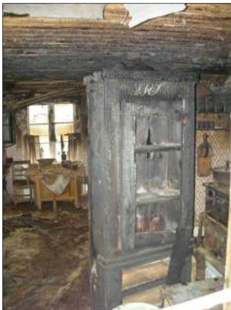
Fotograf är Christer Andersson. Bilden är från en brand i Öckerö hembygdsgård där ett oljefyllt element fattat eld. Skadan inträffade i oktober 2011 och beräknas kosta ungefär 400 000 kr. Bilden nedan J. Fornedal, 2010.
