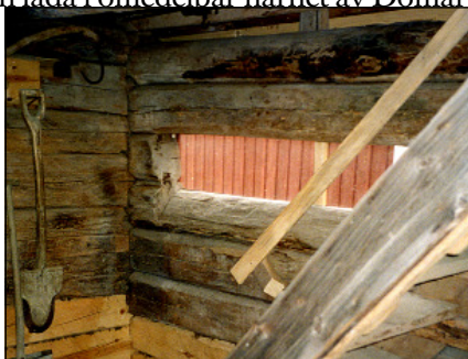
Utsågad öppning med fasad nederkan i ladans hela längd.
